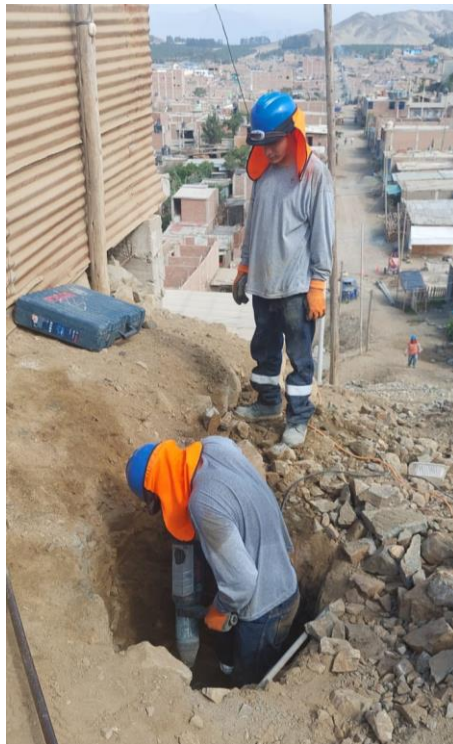
1.- Apertura de hoyos para poste y retenida en terreno rocoso
